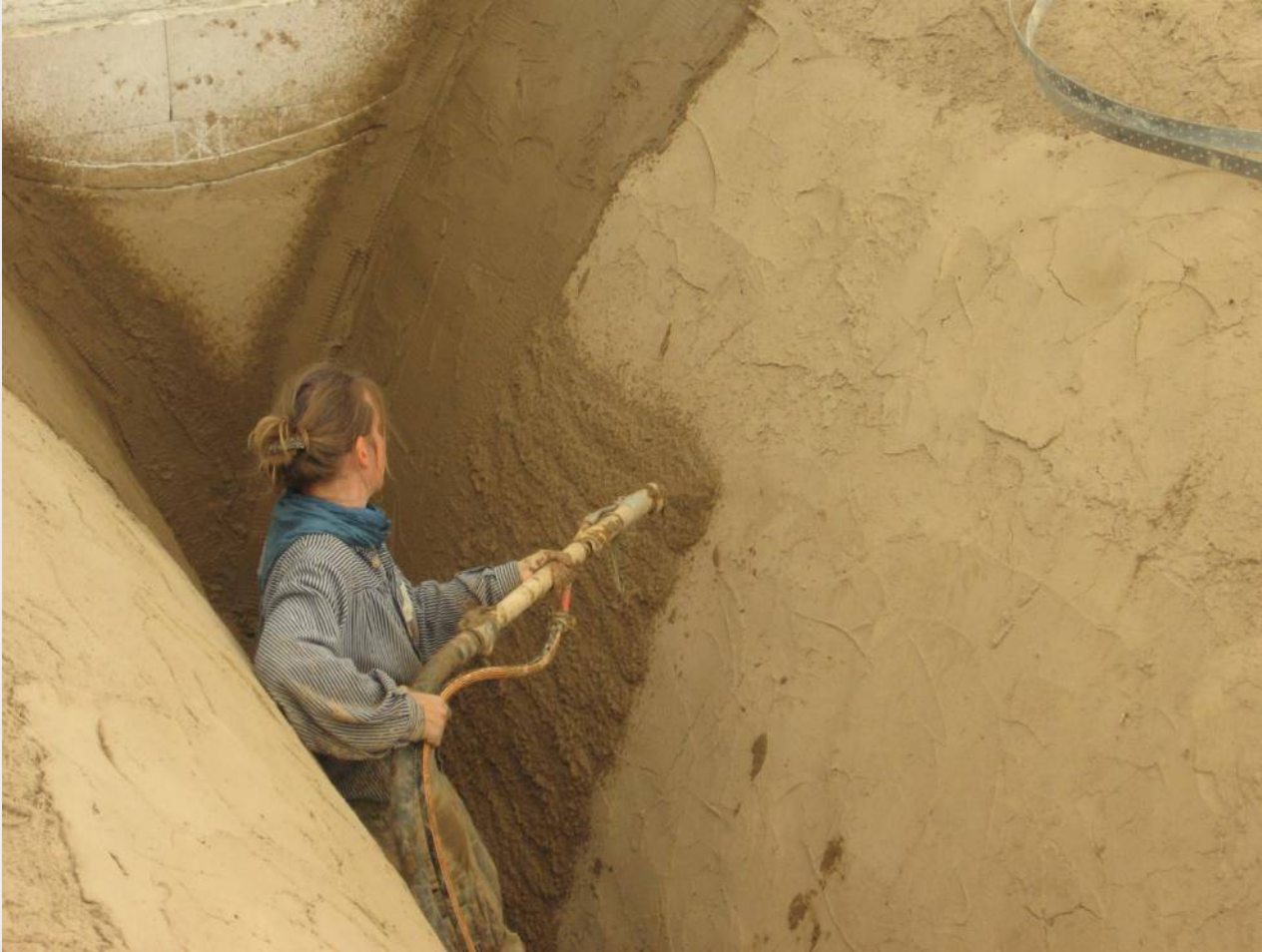
Projection d'enduits sur Voutes en Paille Porteuse
