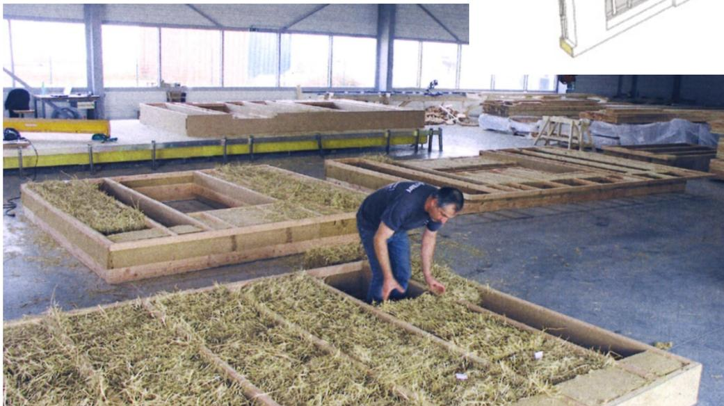
La reconnaissance de la construction Bois-Paille s'est faite avec les règles professionnelles de construction en paille validées en 2012. Ces règles professionnelles permettent de considérer les constructions en ossature bois avec remplissage paille comme des techniques de construction courante, à l'instar des murs ossature bois.
